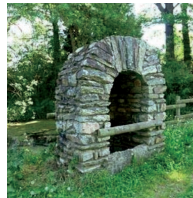
Fontaine de Riavaux
