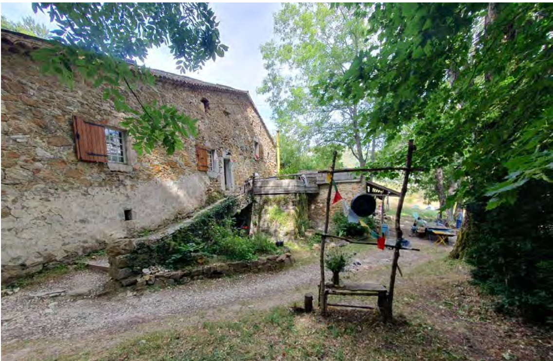
Ancienne ferme du Villard dit la Comtesse
